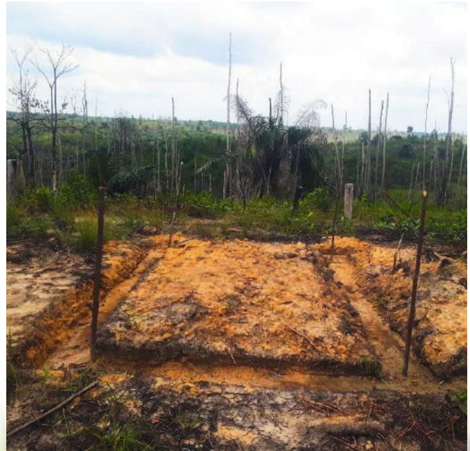
建設時の様子
