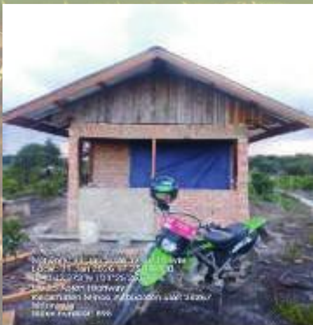
建設時の様子
