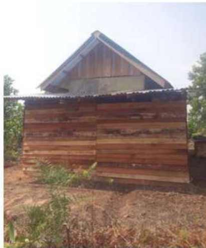
完成した警備小屋
