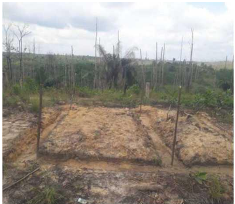
建設現場の様子
