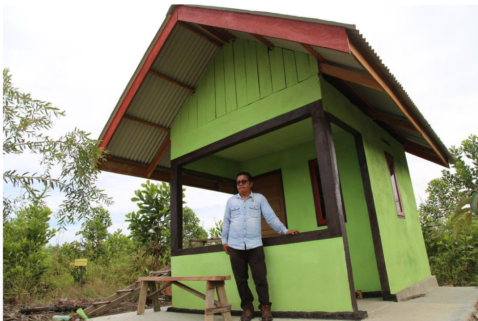
完成した見張り小屋
